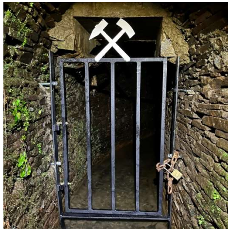
Neugestaltung des Eingangsbereich des Besucherbergwerks in Sprockhövel
